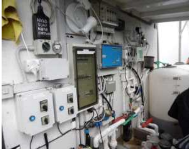
영양분 및 수분, 온도 등 온실 자동 조절 시스템
